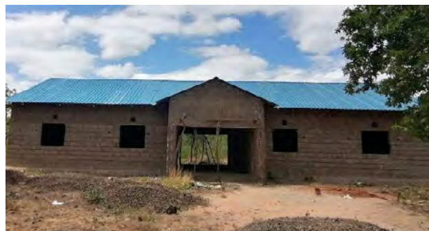
Das im Bau befindliche Verwaltungsgebäude der neuen Nzouni Primary School
